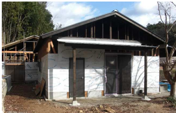
手造りで建設中の農産物加工場
