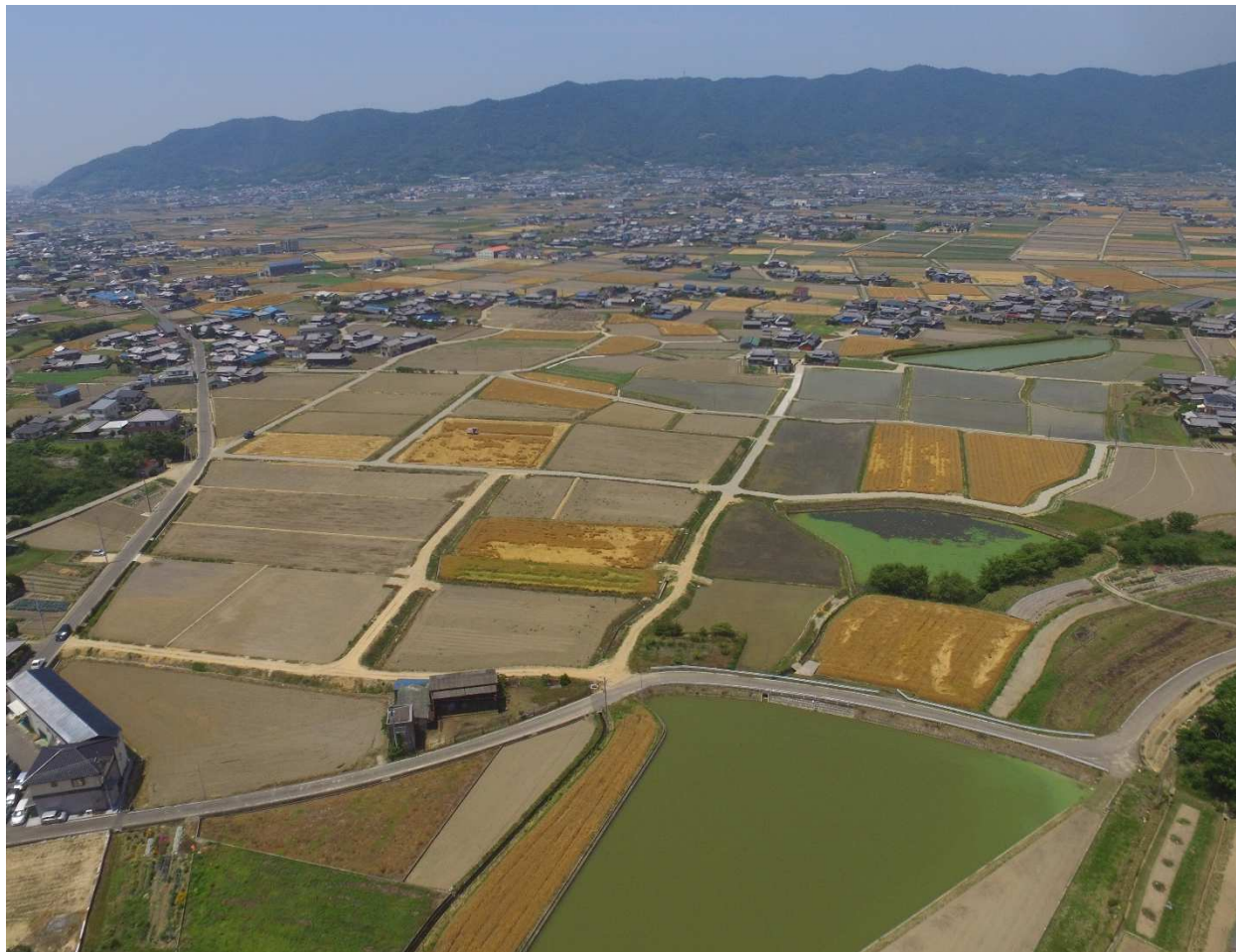
集落営農推進生産基盤整備事業笠田長池地区・笠田土井地区（三豊市）
