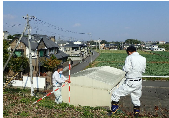
堤防裏面の状況調査
