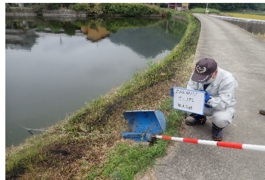
取水施設の状況調査
