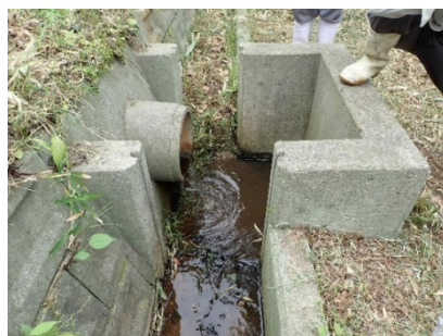
1. ため池樋管の出口よりカメラ挿入
