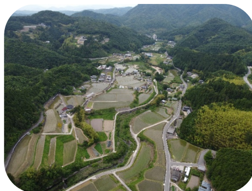
県営中山間地域総合整備事業 塩江地区栂川団地
