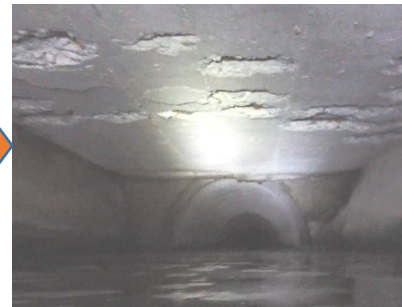
調査した床版がかかった水路内
