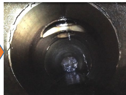
ため池樋管内部
