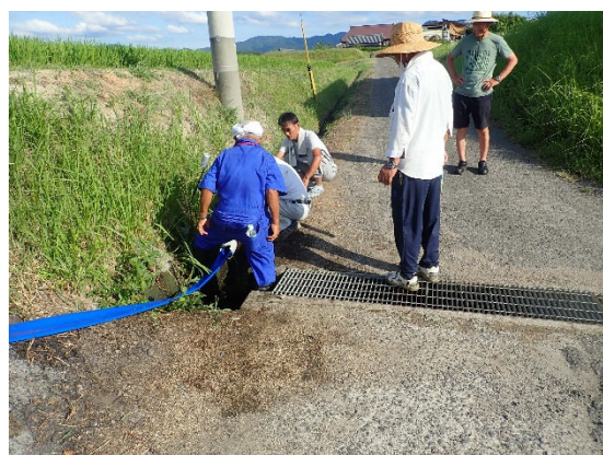
小型ポンプと接続ホースの設置状況
