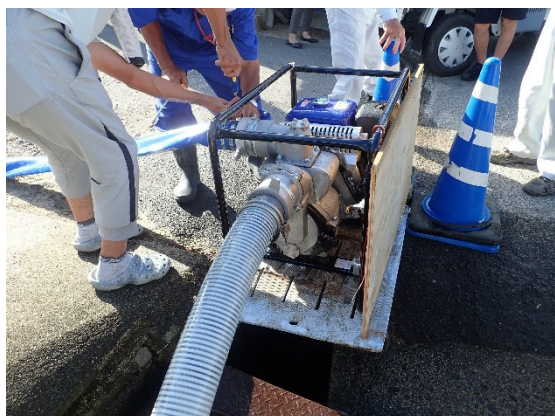
小型ポンプと接続ホースの設置状況
