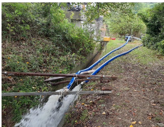
水路への取水状況
