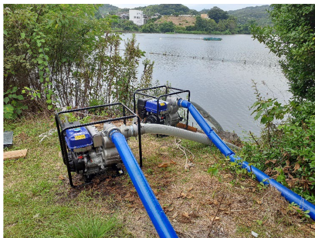
ポンプ設置状況
