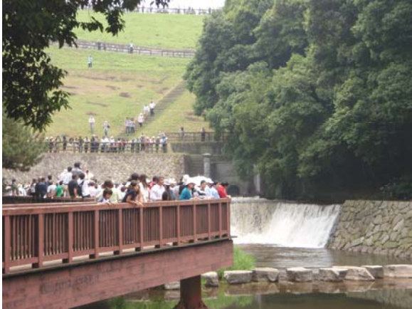
満濃池樋門放流状況（下流より撮影）
