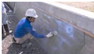
老朽化した水路壁の補修
