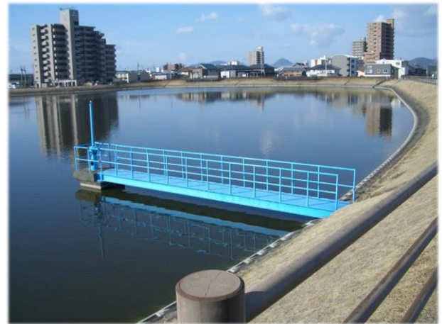
安全施設が整備された大池
