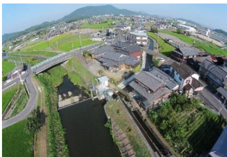
丸亀幹線水路 取水堰
