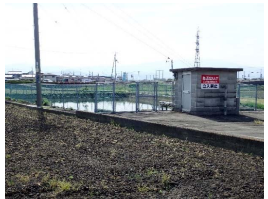
出水（池）とポンプ施設
