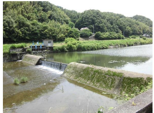
萱原水頭首工 全景
