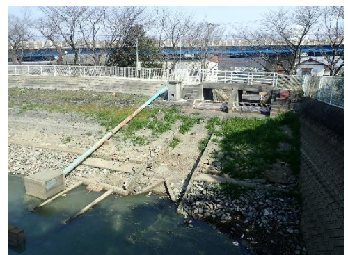
鎌田池洪水吐とパイプライン取水口
