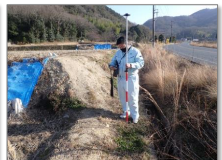
(GISで確認しながら測設)
