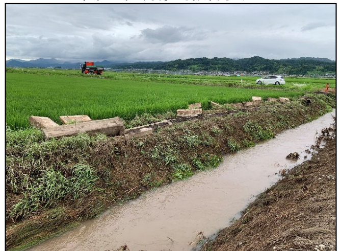
令和2年7月豪雨被害状況
