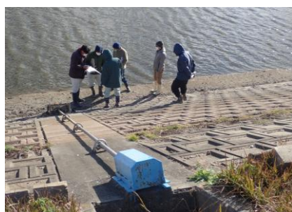
堤防前面劣化調査
